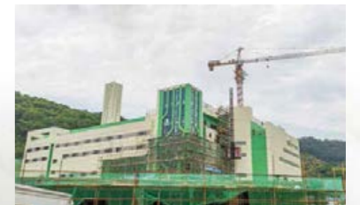
无害化公司广州医疗废物处置项目封顶
