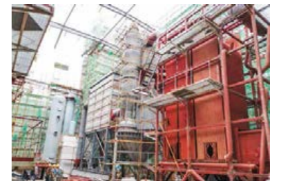
无害化公司广州医疗废物处置项目焚烧设备安装就位
