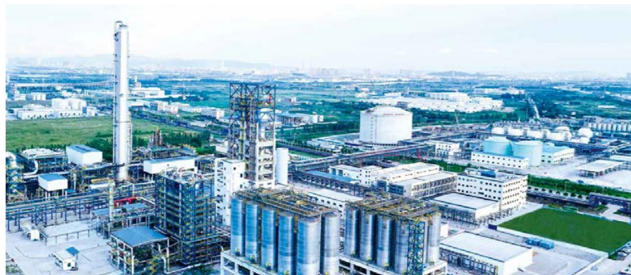
10 月 26 日, 广物控股集团丙烷脱氢制聚丙烯项目一期年产 60 万吨工程建成投产
